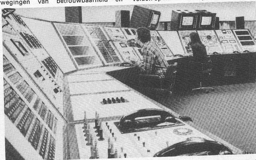
Afb. 2. Links en midden de beide audio contributiepanelen met hun meetapparatuur. Geheel links één van de telefoonpanelen en rechts de video schakel- en meetpanelen.
